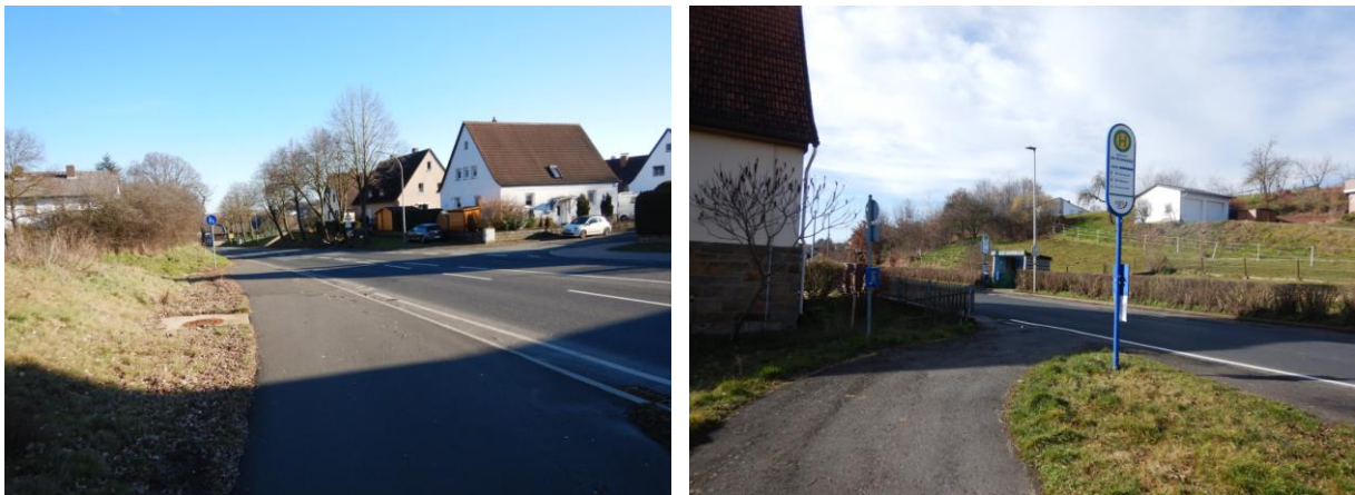
Abbildung 16: Fehlende Überführung vom Radweg auf die Fahrbahn am Ortseingang von Angenrod (Alsfeld) und am Ortseingang von Grebenau aus Wallersdorf kommend (Quelle: Eigene Aufnahmen)
