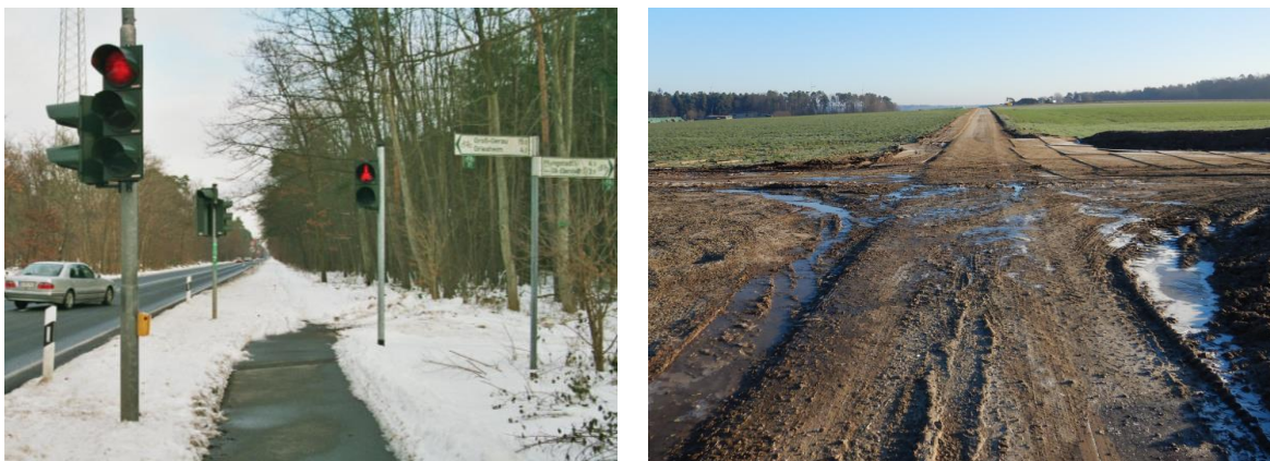
Abbildung 20: Ende eines geräumten Radweges an einer Gemarkungsgrenze / verschmutzter Wirtschaftsweg (Quelle: Eigene Aufnahmen)
