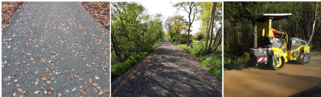
Abbildung 11: Asphaltähnliche Deckschichten aus Gemisch von Basaltstein und Spezialsanden / heller Split-Mastix-Asphalt (Quelle: Eigene Aufnahmen)
