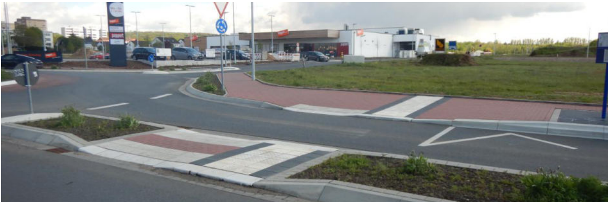
Abbildung 12: Bordsteinabsenkung nach aktuellem Standard mit taktilen Elementen und differenzierter Bordsteinhöhe (Nullniveau und 3-cm-Bord für Taststöcke) in der Adolf-Reichwein-Straße
