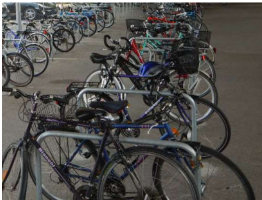
Abbildung 1: Typ Anlehnbügel (geeignet)
