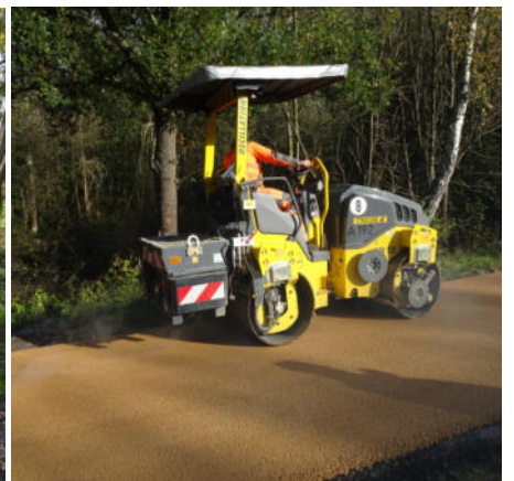
Abb. 2-3: Alternative asphaltähnliche Oberflächen aus Basaltstein und Spezialsanden (Quelle: BioSi Balastan®, Schweizer ideen-Werkstatt) / Abb. 4: Heller Split-Mastix-Asphalt
