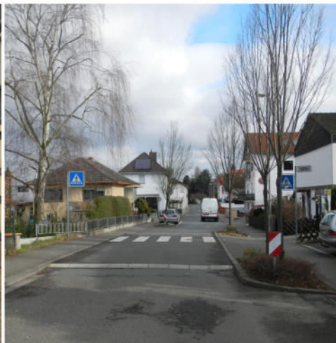
Beispiel 2: Aufpflasterung und Einengung
