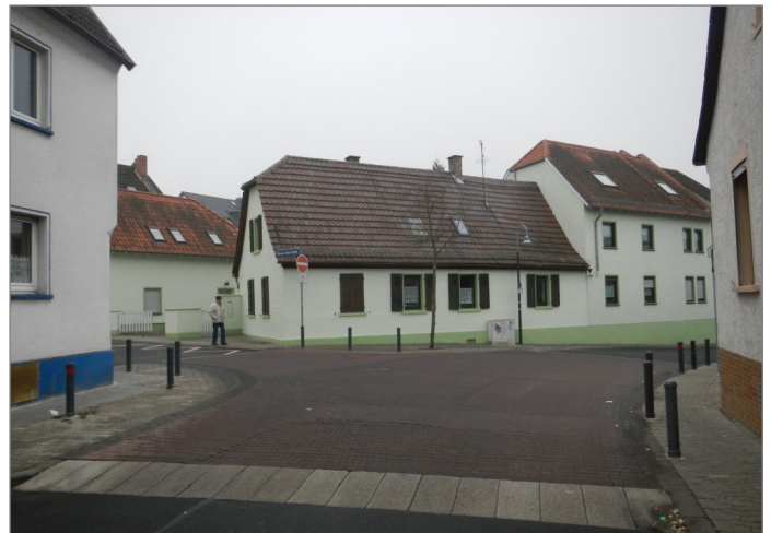
Abbildung 3: Fahrbahnanhebung mit wechselnder Fahrbahnoberfläche und Pollern (schmale Seitenräume; eigene Aufnahme)
