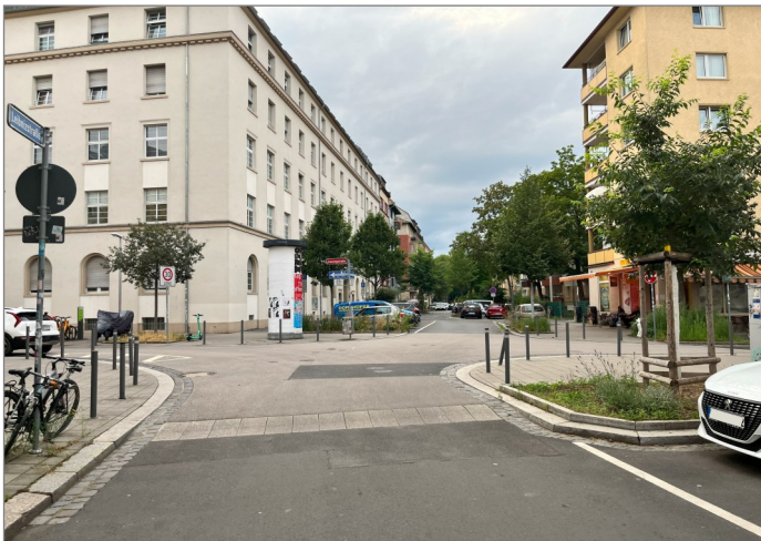
Abbildung 2: Fahrbahnanhebung im Kreuzungsbereich mit vorgezogenen Seitenräumen (eigene Aufnahme)
