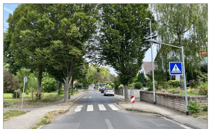
Abbildung 3: bevorrechtigte Überquerungsstelle mit vorgezogenem Seitenraum ohne Fahrbahnanhebung (eigene Aufnahme)
