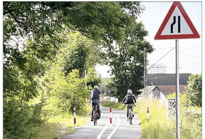
Abbildung 1: Sperrpfosten mit umlaufender Markierung und Verkehrszeichen (Quelle: ADFC Oberursel)
