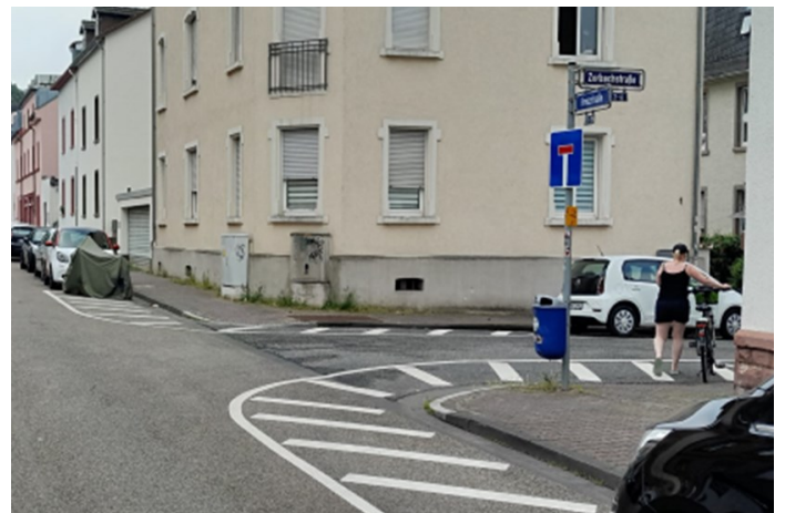
Abbildung 3: Fahrbahnanhebung und Markierung von Sperrflächen im Bereich der Einmündung (eigene Aufnahme)
