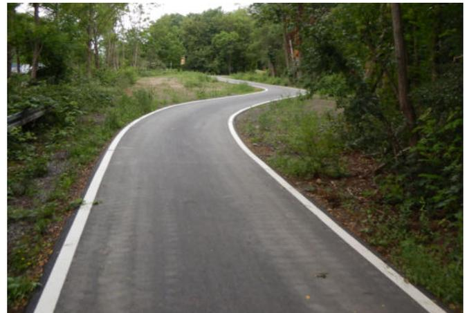
Abb. 2: Asphaltierter Geh- und Radweg mit fahrdynamischer Linienführung und Randmarkierungen
