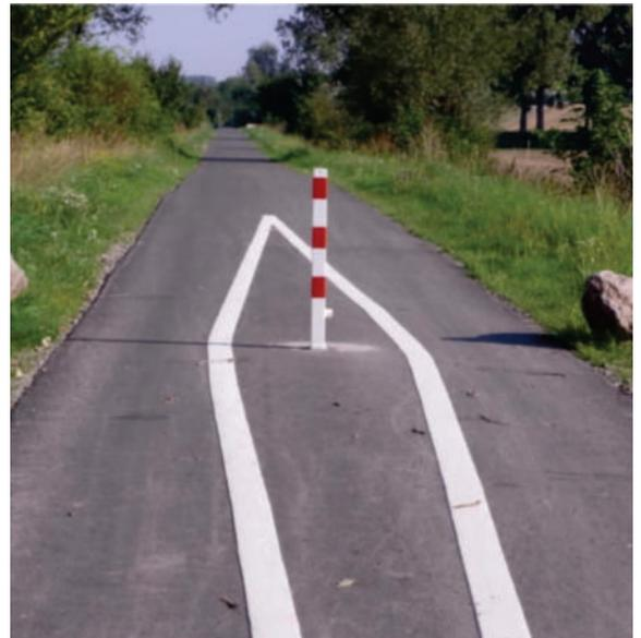
Abbildung 1: Warnmarkierung eines Sperrpfostens
