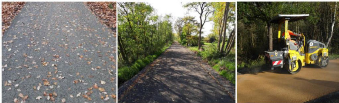
Abbildung 8: Asphaltähnliche Deckschichten aus Gemisch von Basaltstein und Spezialsanden / heller Split-Mastix-Asphalt
