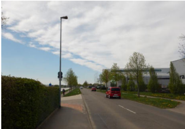
Abbildung 6: Fehlende Überführung auf Radweg am Ortsausgang Richtung Sielmingen
