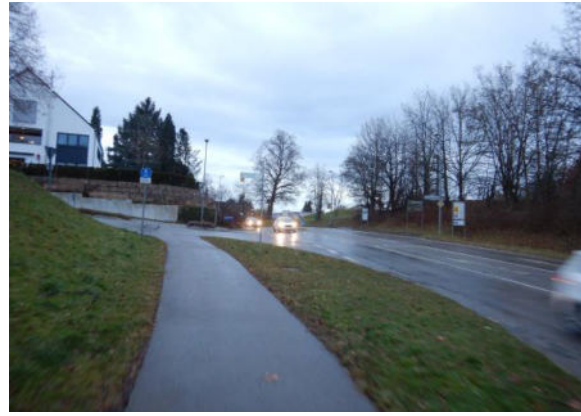
Abbildung 7: Ungeeignete Überführung auf die Fahrbahn am Ortseingang aus Richtung Wolfschlugen
