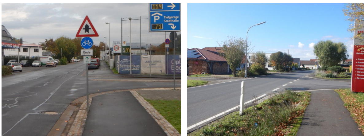
Abbildung 8: Fehlende Überführung auf die Fahrbahn in Lohr a. Main auf der Jahnstraße (links), fehlende Überführung auf die Fahrbahn auf der Hausener Straße zwischen Steinfeld und Hausen (rechts) (Quelle: eigene Aufnahmen)
