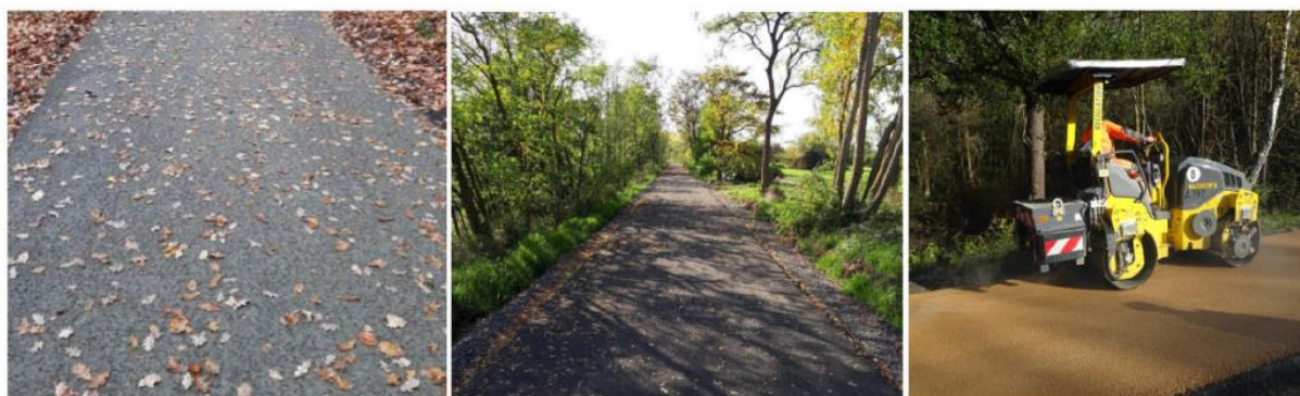
Abbildung 10: Asphaltähnliche Deckschichten aus Gemisch von Basaltstein und Spezialsanden / heller Splittmastixasphalt (Quelle: eigene Aufnahmen)
