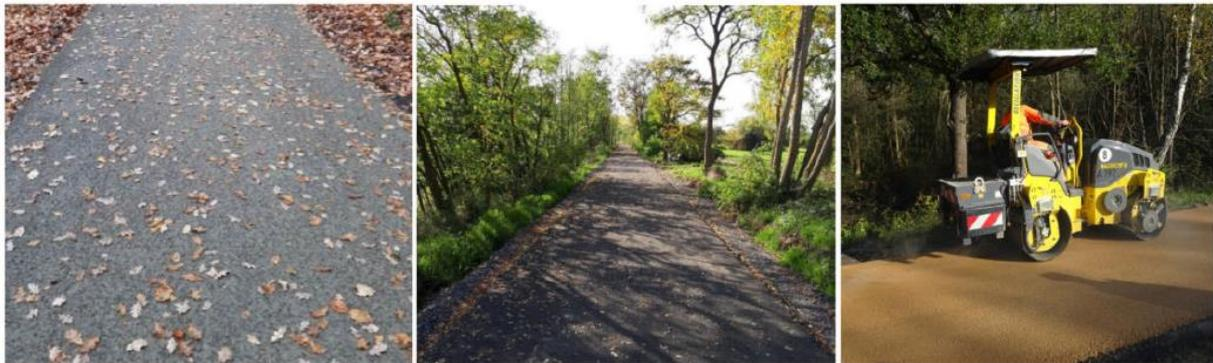
**Abbildung 6:** Asphaltähnliche Deckschichten aus Gemisch von Basaltstein und Spezialsand (links, Mitte), heller Split-Mastix-Asphalt (rechts) (Quelle: Planungsbüro RV-K).
