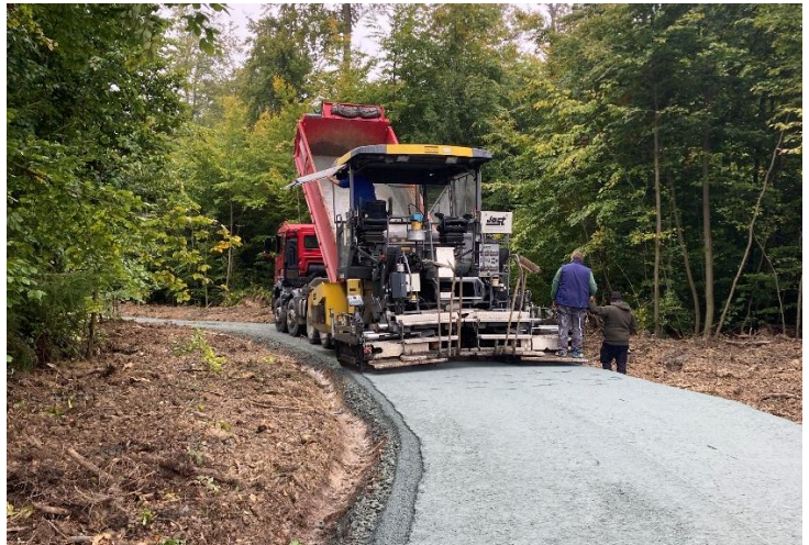
Asphaltieren eines Rad-Wirtschaftsweges zwischen Usingen und Willmersdorf 2025 (eigene Aufnahme)
