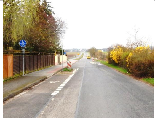
Übergang in Lörzweiler mit baulichem Schutz und Fahrbahnverschwenkung (eigene Aufnahmen)
