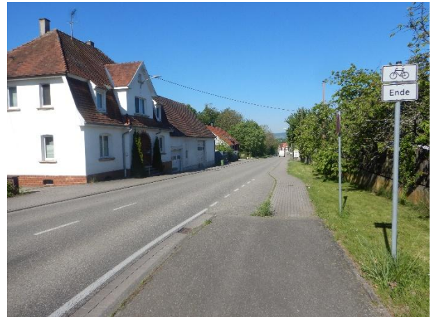
Vorhandener baulich geschützter Übergang zwischen Radweg und Fahrbahn in Hergersweiler (eigene Aufnahme)
