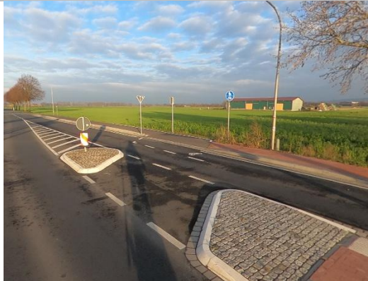
Übergang Fahrbahn-Radweg mit Mittelinsel in Bückeburg, Niedersachsen (eigene Aufnahme)
