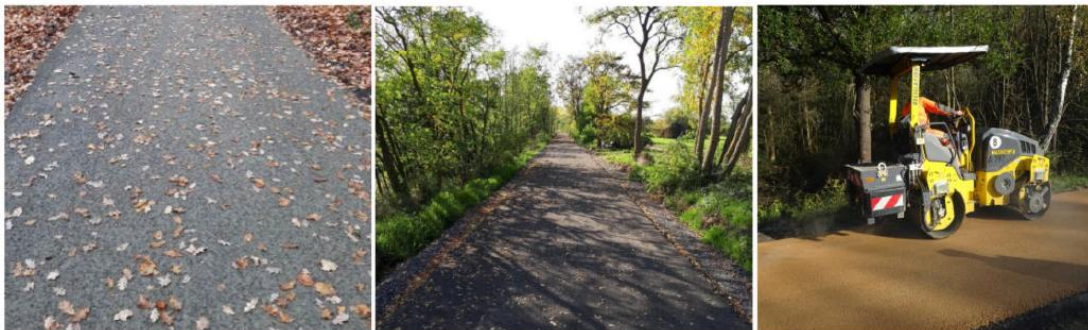
Abbildung 9: Asphaltähnliche Deckschichten aus Gemisch von Basaltstein und Spezialsanden / heller Split-Mastix-Asphalt (Quelle: Eigene Aufnahmen)
