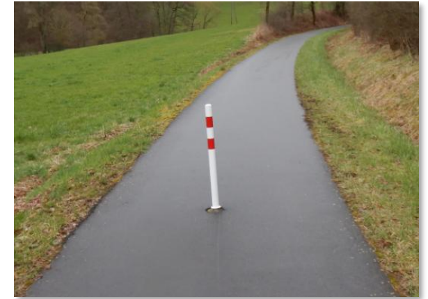
Sperrpfosten ohne Bodenmarkierung auf einem Radweg (Quelle: Eigene Aufnahmen)
