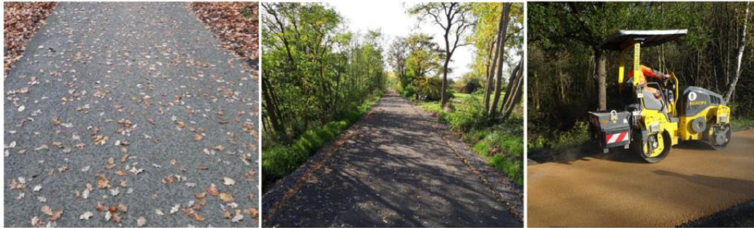
Abbildung 10: Asphaltähnliche Deckschichten aus Gemisch von Basaltstein und Spezialsanden / heller Split-Mastix-Asphalt, (Quelle: Eigene Aufnahmen)
