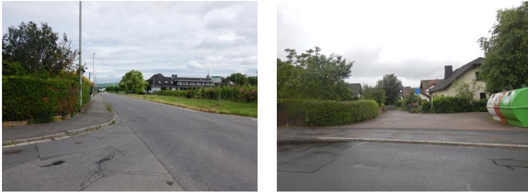
Abbildung 19: Beispiele nicht abgesenkter Bordsteine in Geisenheim (Eigene Aufnahmen)
